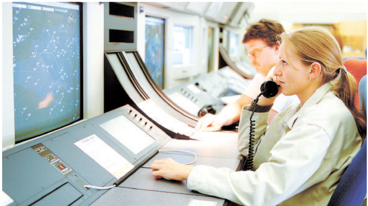
Kritische Flugsicherheitsdaten aus einer Hand bietet die von Frequentis bereitgestellte EAD. Das IT-Service ist nunmehr an das Wiener Rechenzentrum von T-Systems ausgelagert. Foto: Frequentis
