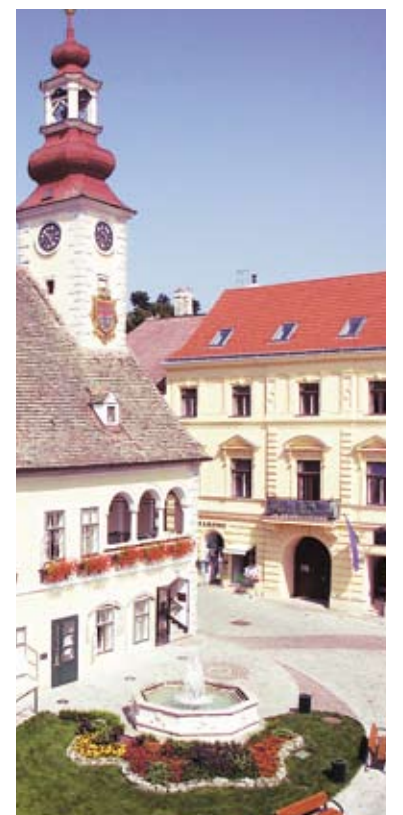
Um die historischen Bauten im Mödlinger Stadtkern zu schonen, werden die Überwachungsdaten per WLAN übermittelt, womit keine Stemmarbeiten für die Leitungsverlegung notwendig wurden. Foto: Helga Schlechta
